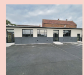
Travaux école primaire
