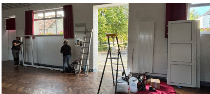
Changement des deux portes antipanique de la salle des fêtes
