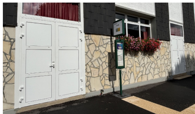
Changement des deux portes antipanique de la salle des fêtes
